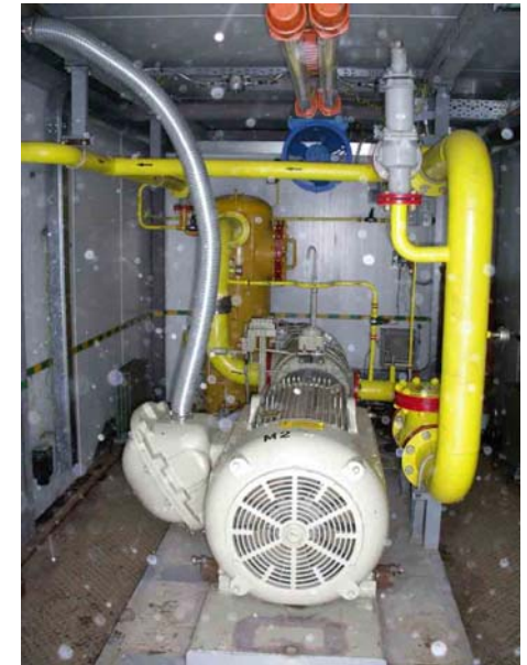
Compressor unit 空压机
