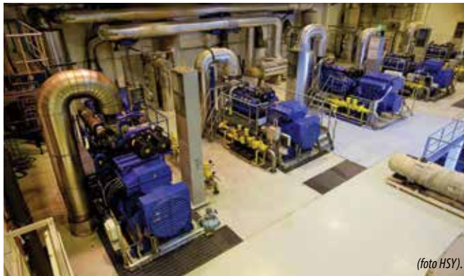
联合热电厂 Viikinmäki WWTP (芬兰赫尔辛基市)
