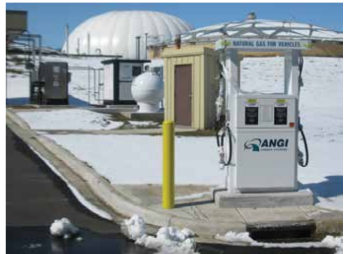
废水沼气转化为压缩天然气 (CNG) 的汽车燃料项目 Janesville WWTP (美国威斯康星州简斯维尔市)
