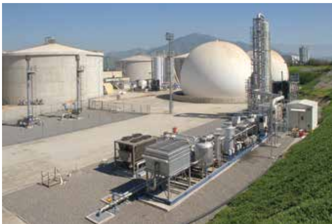
厌氧消化池和沼气处理设施 La Farfana WWTP (智利圣地亚哥市)
