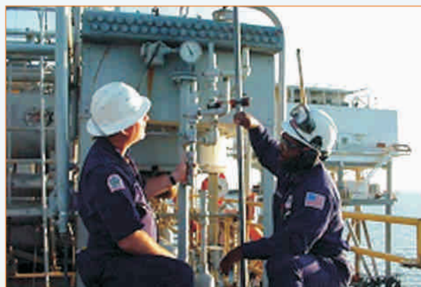
Figura 2: L'installazione di valvole a bassa emissione possono rappresentare una soluzione per ridurre le perdite di gas.
