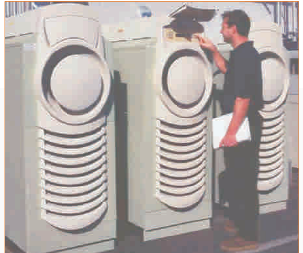
Tre microturbine da 30 kilowatt alimentate a gas da discarica in California (USA)
