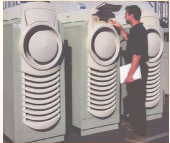
在美国加州，有三台以填埋场气体驱动的30千瓦微型涡轮机。
