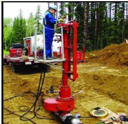
Un técnico certificado de Williamson Industries realizando el hot tapping con una máquina Tapping 760 como parte de la aplicación de un tapón de 12 pulgadas.
