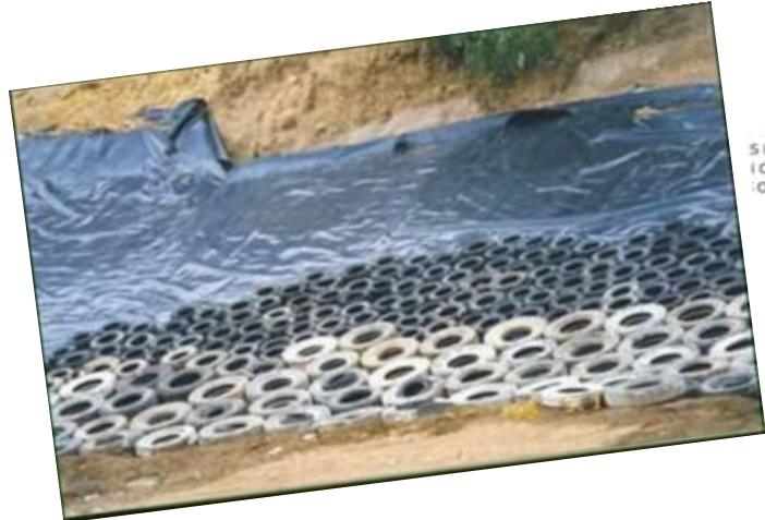
Protección de la geomembrana con llantas
