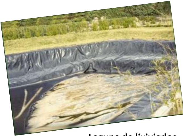
Laguna de lixiviados
