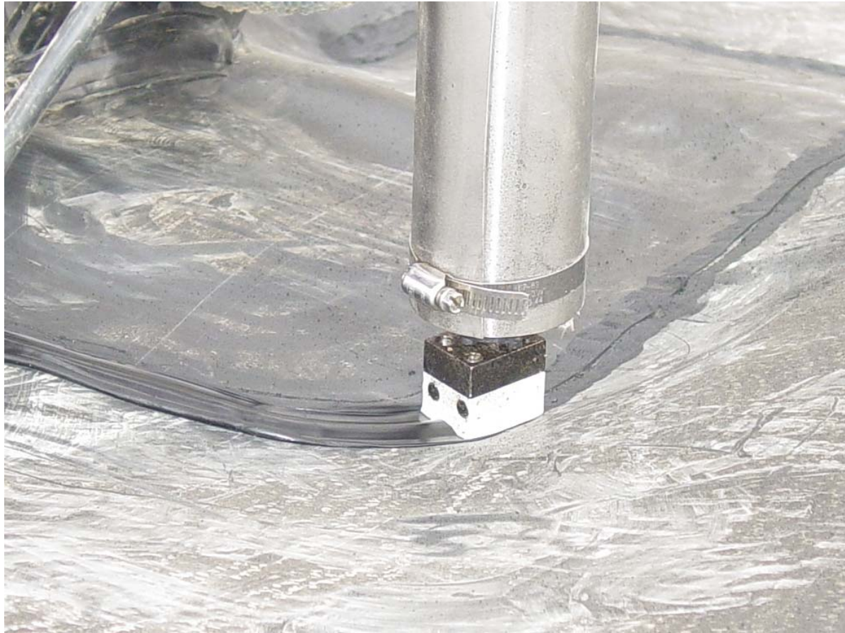
破坏性焊接测试之后修补漏洞
