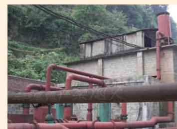
Figure 3. Station de pompage dans la région d'extraction du charbon de Songzao
