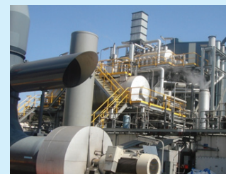
Figure 2. Centrale de traitement du méthane de ventilation à la mine West Cliff Colliery de BHP Billiton, en Australie
