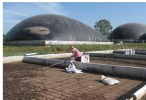
带有前置固体干燥坑的厌氧沼气池（泰国）
