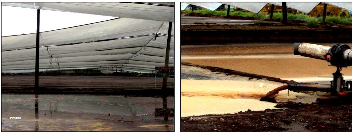
Figura 16: Piscinas de almacenamiento de vinazas
