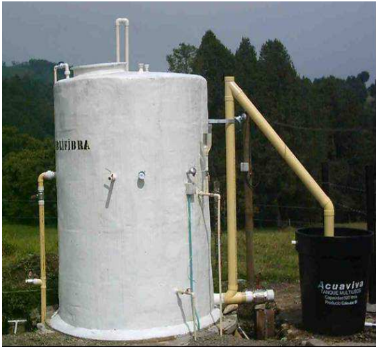
Figura 3: Tanque de digestión anaeróbica y reservorio de biogás
