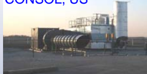
Abatement demo CONSOL, US
