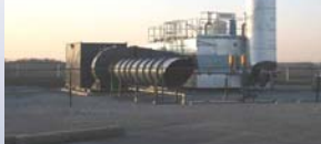
Abatement demo CONSOL, US
