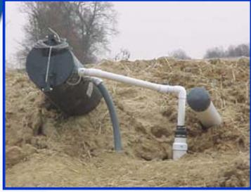
安装收集管，把渗透的液体从处理单元中抽吸到渗滤液收集放池。
