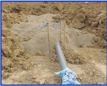
然后安装穿孔的 PVC 管。此层是主要的渗滤液收集层, 它会收集垃圾渗漏出的液体。
