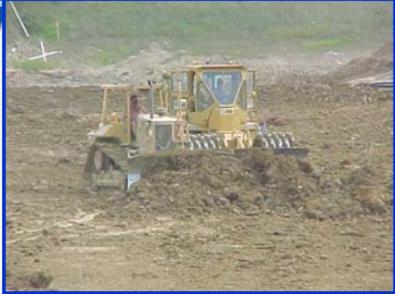
然后在渗滤液收集管和塑料层上覆盖18英寸厚的保护土层。
