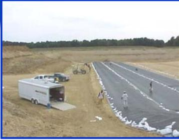
60 mil 高密度聚乙烯 HDPE (High Density Polyethylene) . 塑料层铺设在土层上, 此过程为第一阶段的渗滤液收集。
