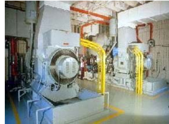
Turbina de Gas (rango de 800 kW a 10.5 MW)
