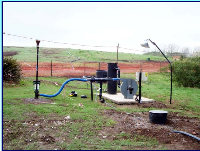
Estación de captación y tratamiento de biogás
